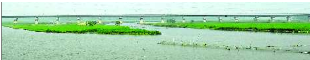
▲作为京沪高铁泰安段最大的跨河大桥,京沪高铁大汶河特大桥全长约21公里,由600多个桥墩组成。
