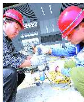
建设者正在加班苦干。
