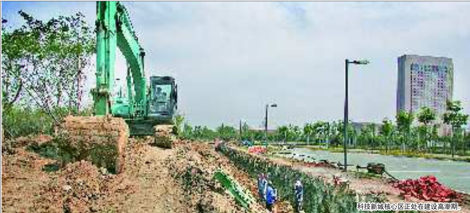
科技新城核心区正处在建设高潮期。
