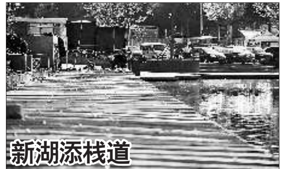
6月13日,施工人员正在安装铺设木栈道,扮靓新湖水岸,为市民提供休闲场所。 本报记者 马志勇 牟张涛 摄
