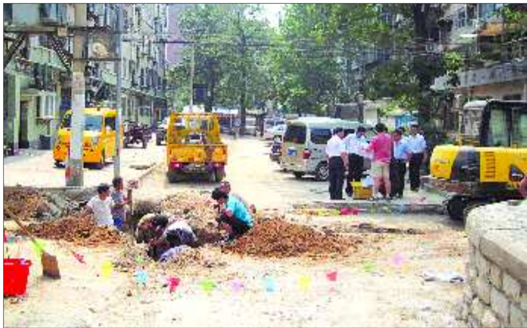
现场正在维修,抢修车停在旁边。本报记者 吴金彪 摄
