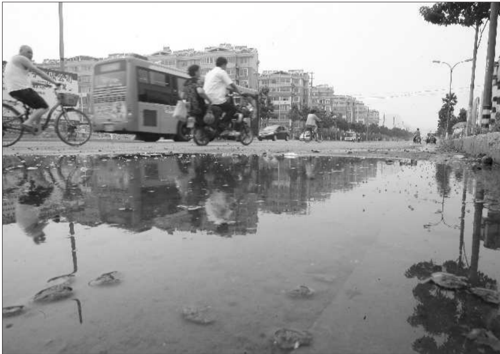
21日,在枣庄市中区解放北路火车站附近,由于房屋拆迁,造成下水道堵塞,使得附近市场排放的污水流到马路上,横流近百米,并发出刺鼻的恶臭。据附近的居民介绍,该处污水横流近三个月了,至今无人清理。 记者 廖杰 见习记者 马明 摄
