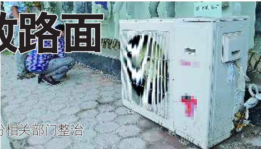
一些街道上的空调外挂机放置较低,有的直接放在地上,没有达到规定高度。 本报记者 赵伟 摄
