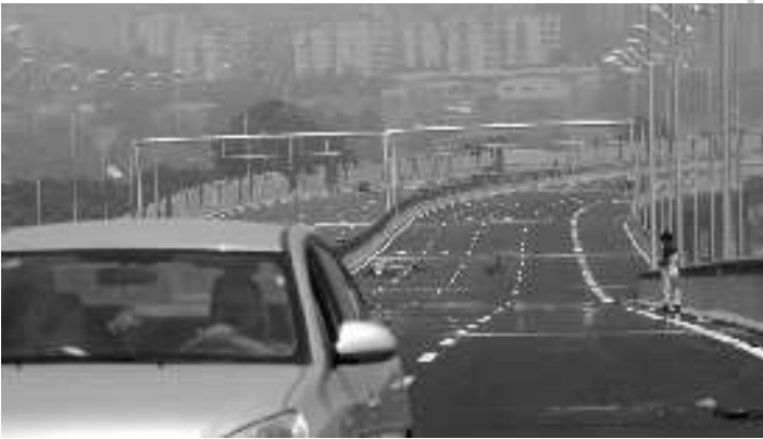
22日,胶州湾大桥接线端主体工程已经完工。 本报记者 杨宁 摄
