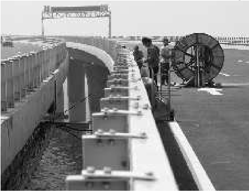
给大桥通电。 本报记者 杨宁 摄
