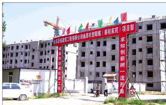
息陬镇高铁回迁居民小区建设主体已经完工。
