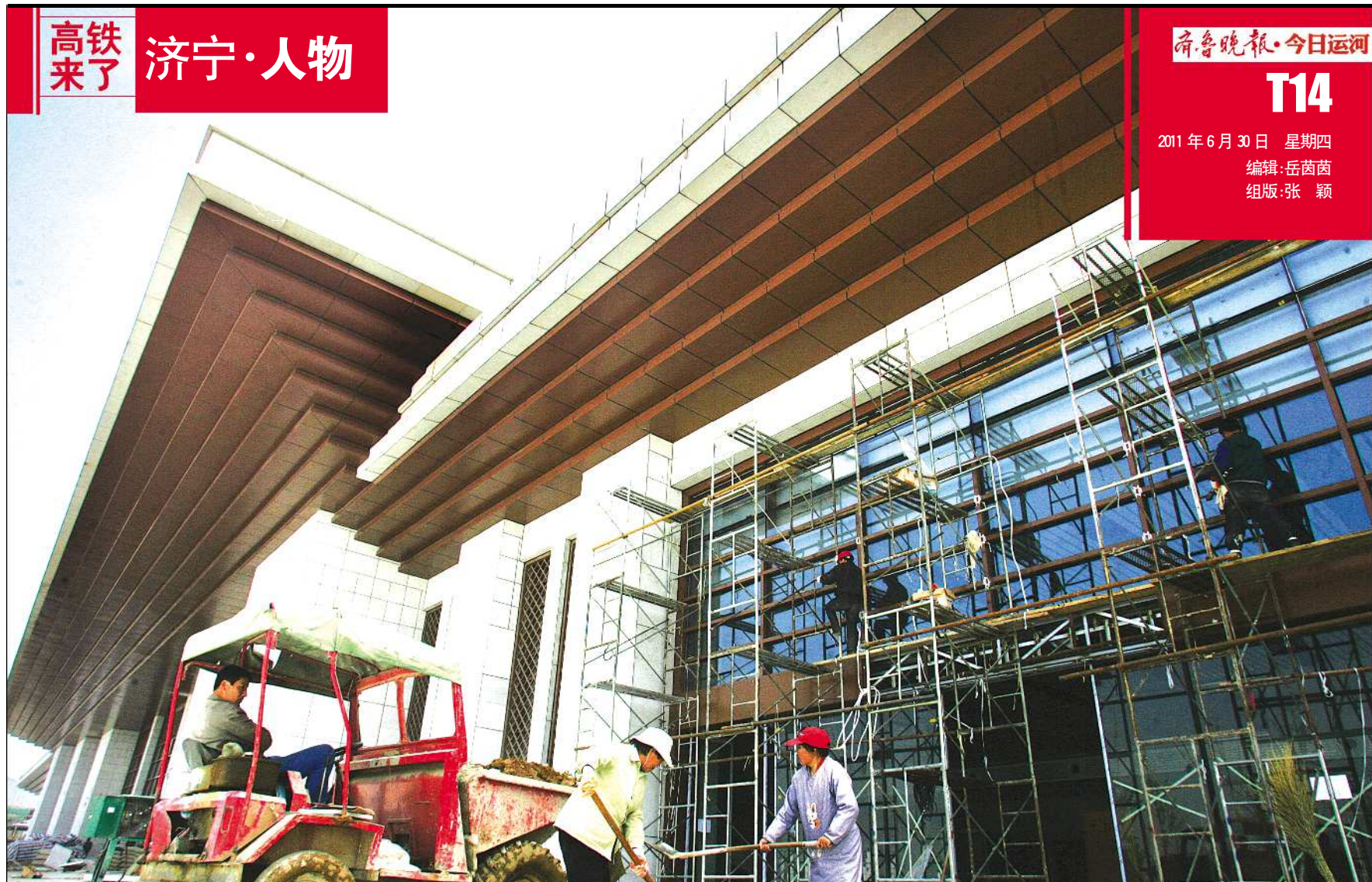
京沪高铁曲阜东站施工现场。(资料片) 本报记者 张晓科 摄
