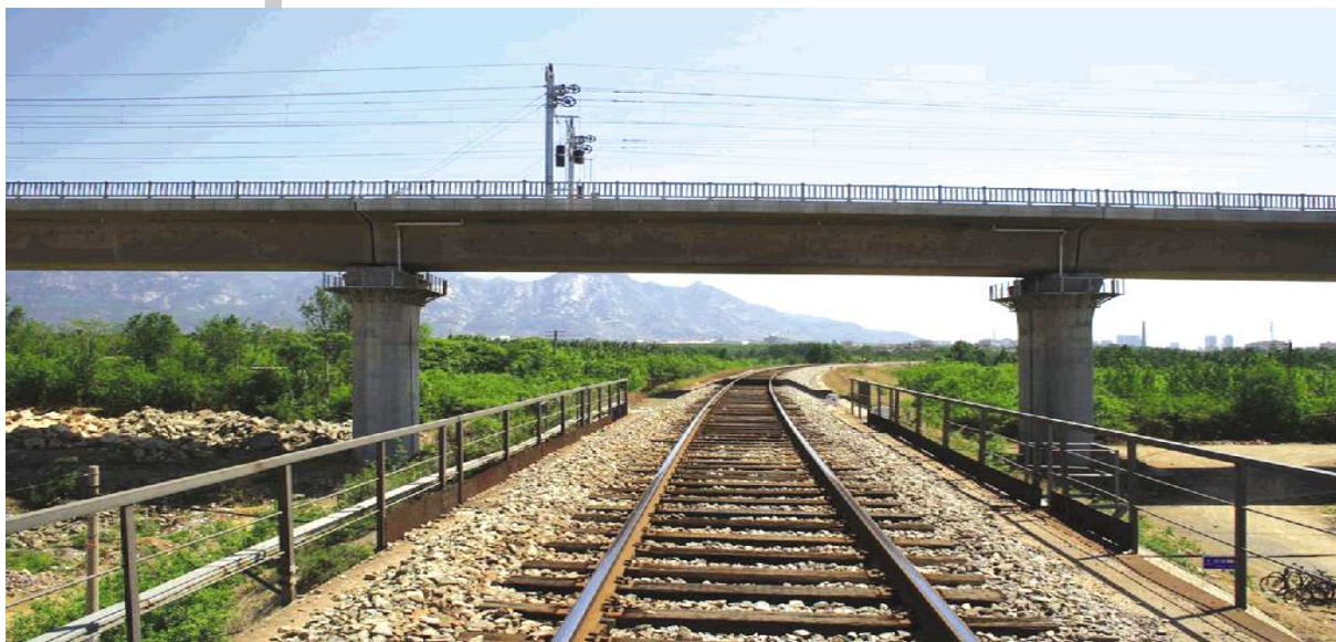
京沪高铁以桥代路减少路基沉降。本报记者 孔红星 摄 (资料片)
