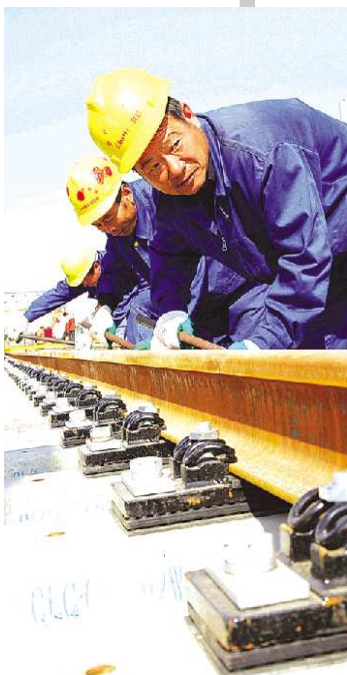
京沪高铁全线铺设无缝线路和无砟轨道，保稳降噪。本报记者 刘丽 摄 (资料片)
