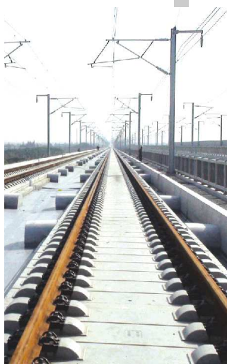
铺设好的高铁轨道。(资料片)
