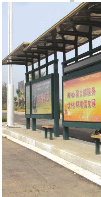
已经安装好的公交站牌。 本报见习记者 王鸿哲 摄
