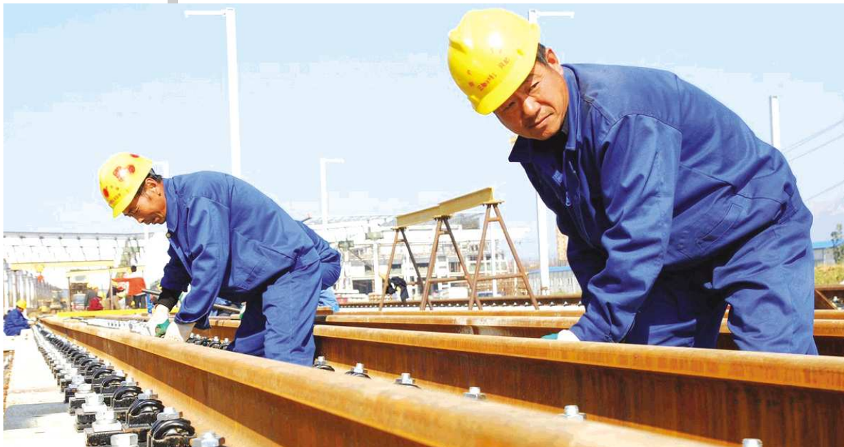
高铁工人对铺设好的铁轨进行加固。(资料片) 本报记者 刘丽 摄
