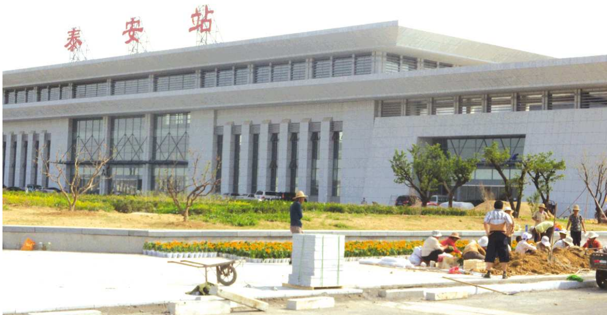
高铁泰安站完成施工。 本报记者 李虎 摄
