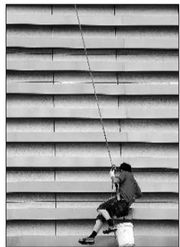
高空作业人员正在对楼房外墙进行清洗。
