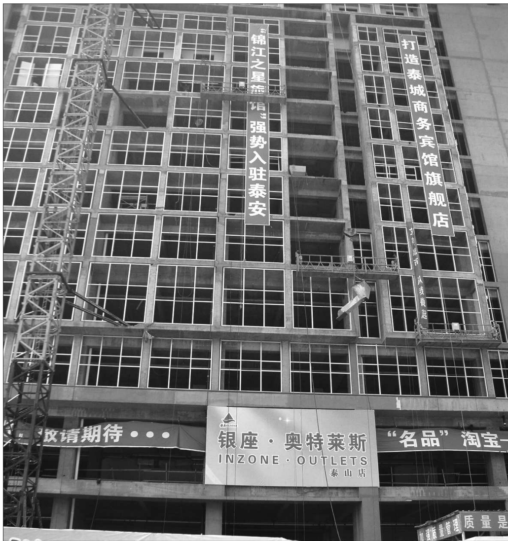
正在装修的银座·奥特莱斯泰山店。本报记者王颜摄
