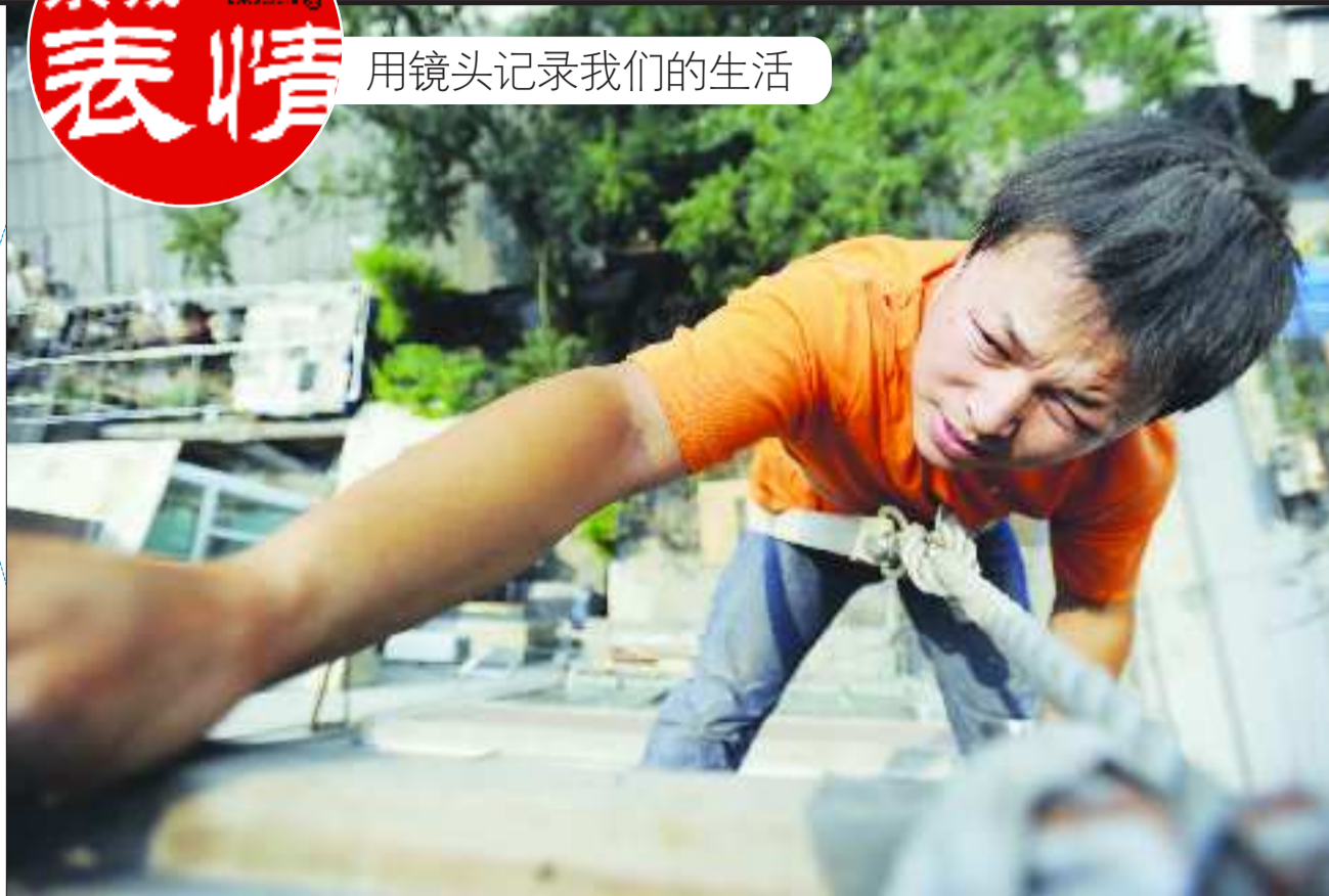
▼这根吊绳直接关系到安装工的人身安全。
