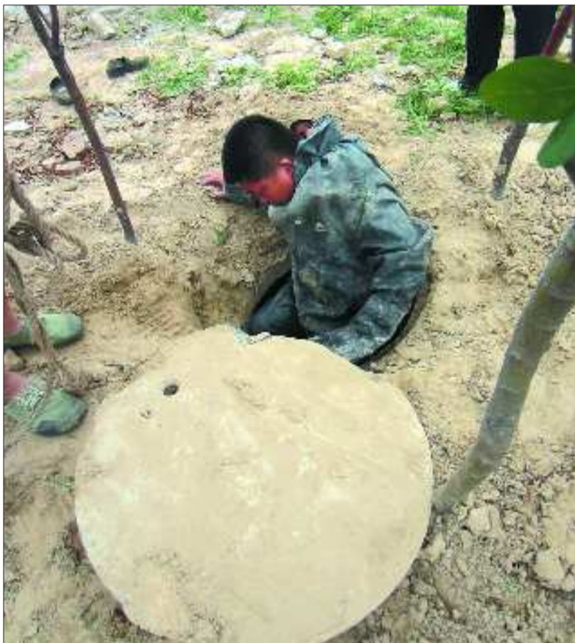
有的污水井,工作人员要亲自下井清淤。记者 张凯 摄
