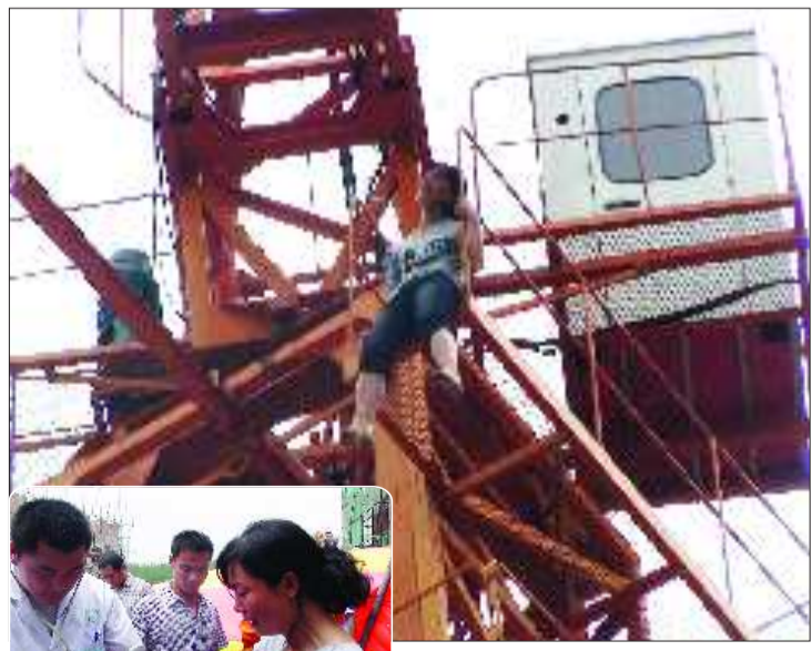
▲女子爬到30多米高的塔吊上。
