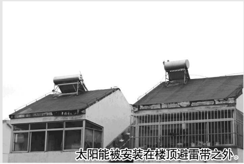
楼顶的太阳能用已经生锈的细铁丝拴在楼顶避雷带上。
