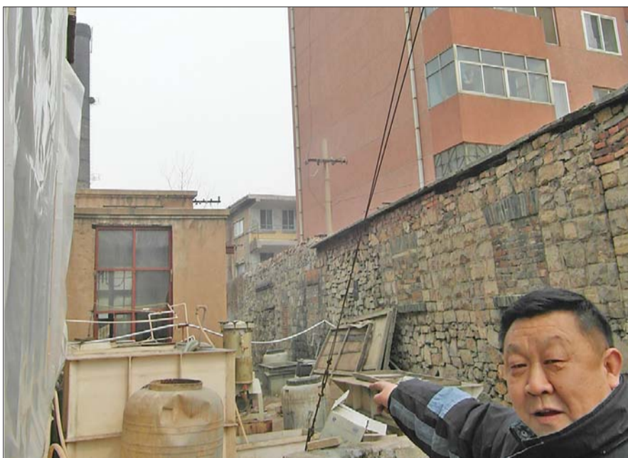
左面为电镀车间,与右面的居民楼只有一墙之隔。
