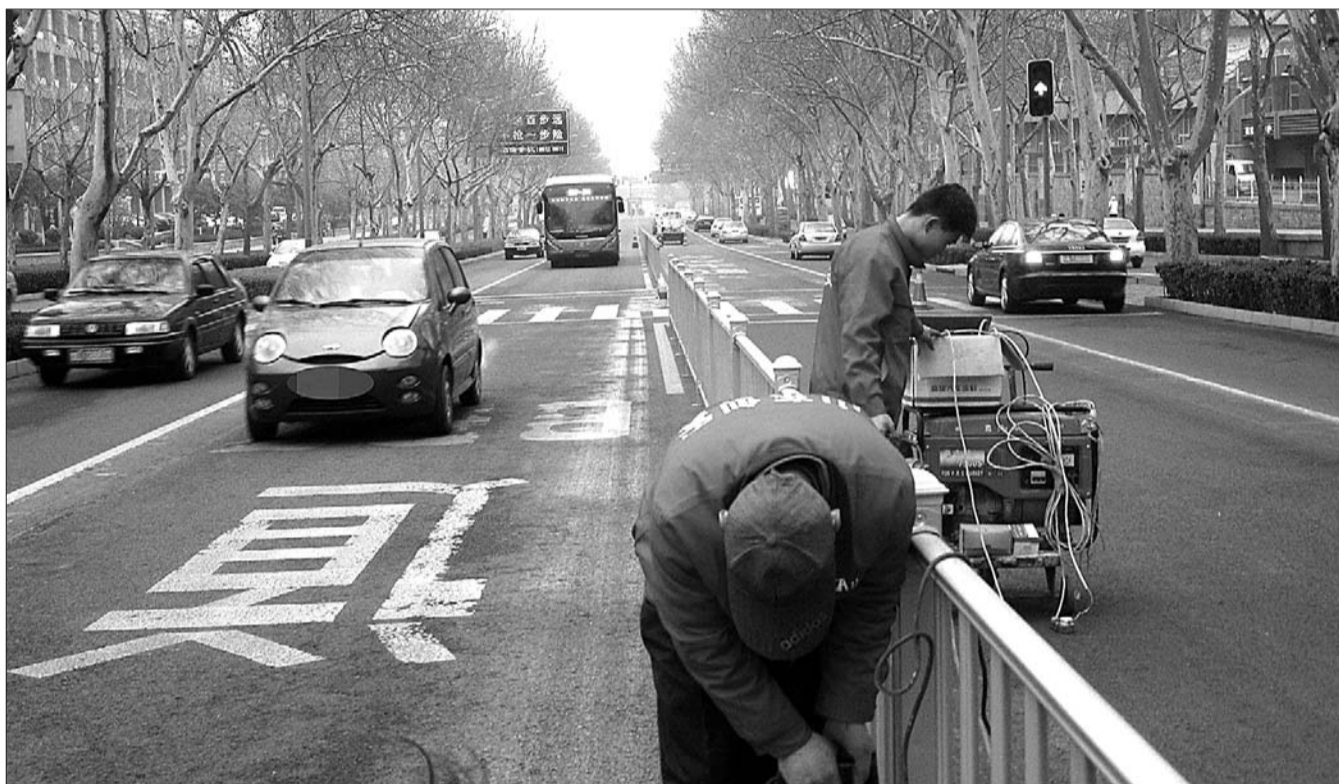
济南历山路南段BRT护栏拆除后,有社会车辆占用快速公交专用道。 本报记者 王倩 摄
