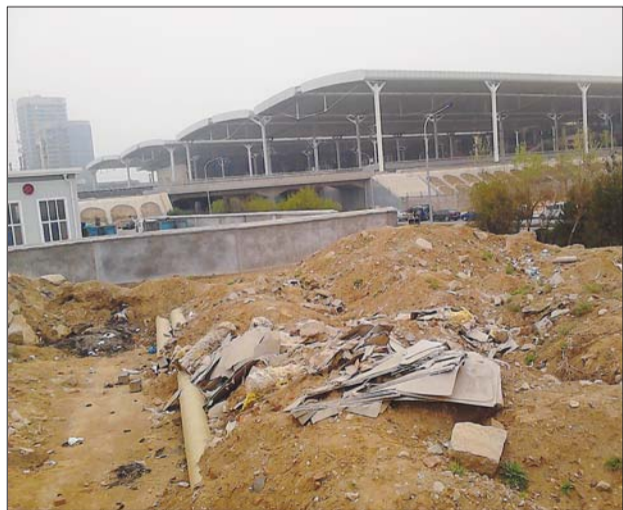
与济南西站相邻的顺安路东侧,建筑垃圾遍布。 本报记者 冯琳 摄
