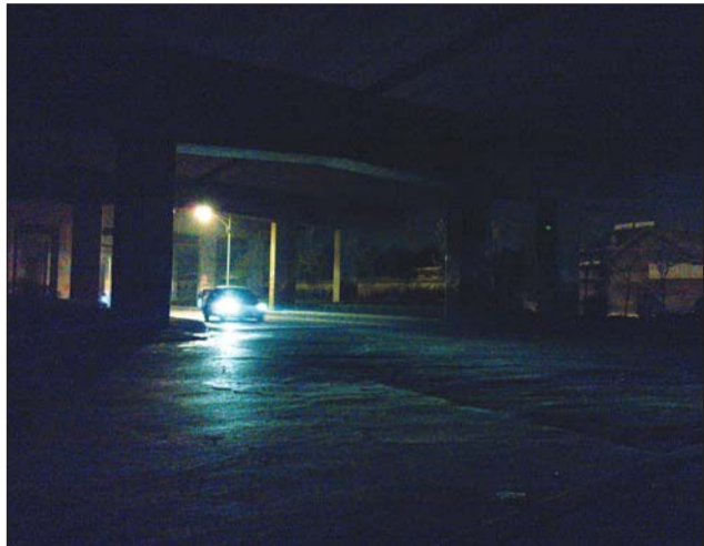
在宋庄立交桥下,连接立交桥下两侧道路的通道亮化严重不足。 记者 任志方 摄
