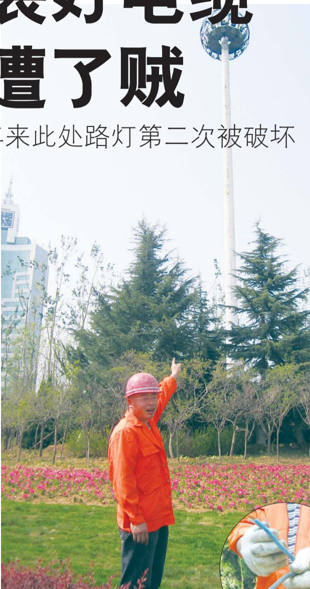
▲被盗取电缆的高杆路灯。记者 侯艳艳 摄 ▶维修工展示被截断的电缆。
