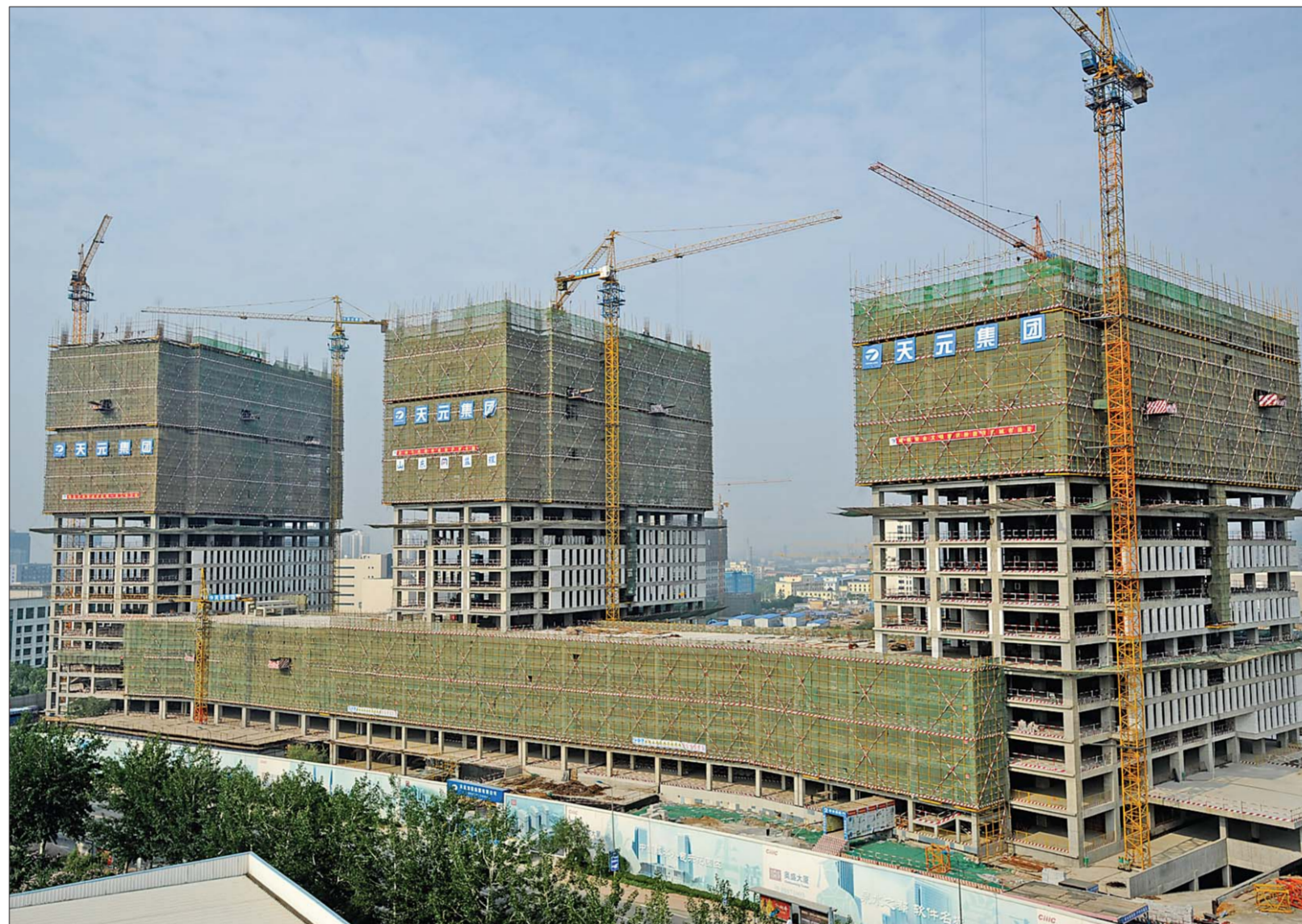
▲正在建设中的“5150”人才大厦,将成为高层次人才创新创业的基地和载体。 本报记者 张中 摄
