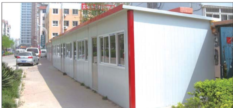
新世界花园小区内新建的一排板房。记者侯冬冬 摄
