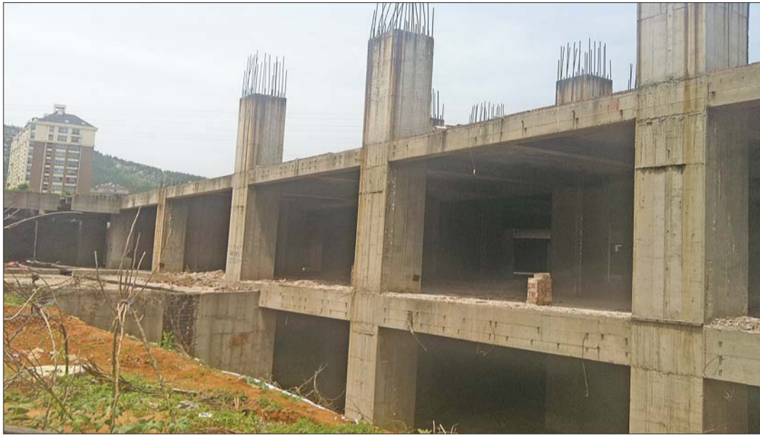
十多年的烂尾楼终于要拆了。
