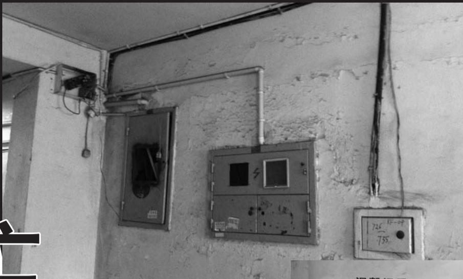
▲在华宝小区一号楼二单元二楼，此处电表总闸的盒子打开着，里面的线头被黄胶带缠着。此外，还有电线插头悬挂在电表盒子外面，没有一丝防护设施。
