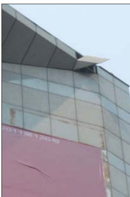
大厦顶层的墙砖已经翘起。记者 侯艳艳 摄
