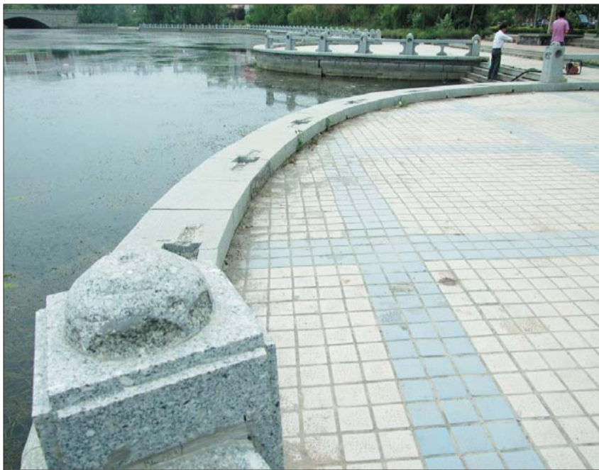
向阳路颐馨园小区对面的运河边,三个半圆形平台周围的护栏大半缺失。
