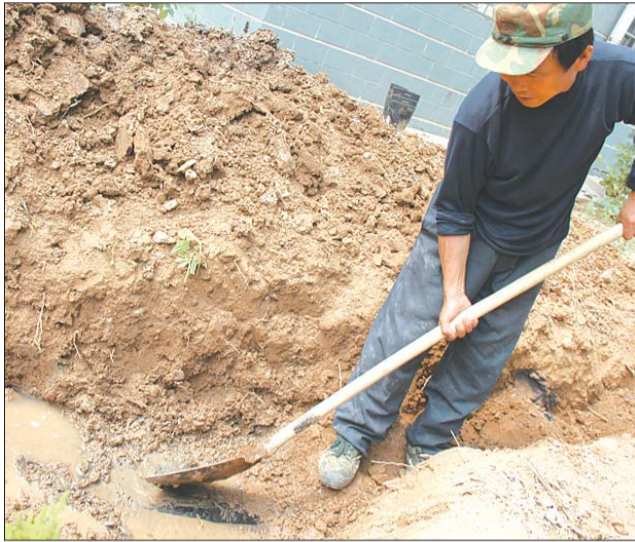
自来水公司的工作人员正在挖新的自来水管通道。本报记者 郑美芹 摄
