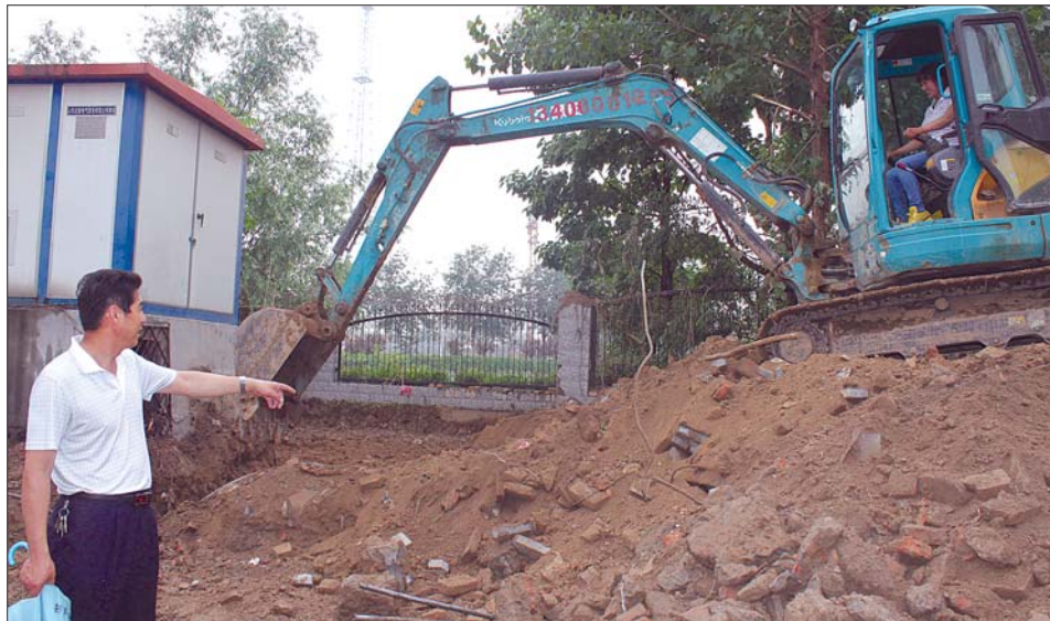
▲在施工现场,一辆挖掘机正紧张开挖新槽。 记者 梁斌 摄
