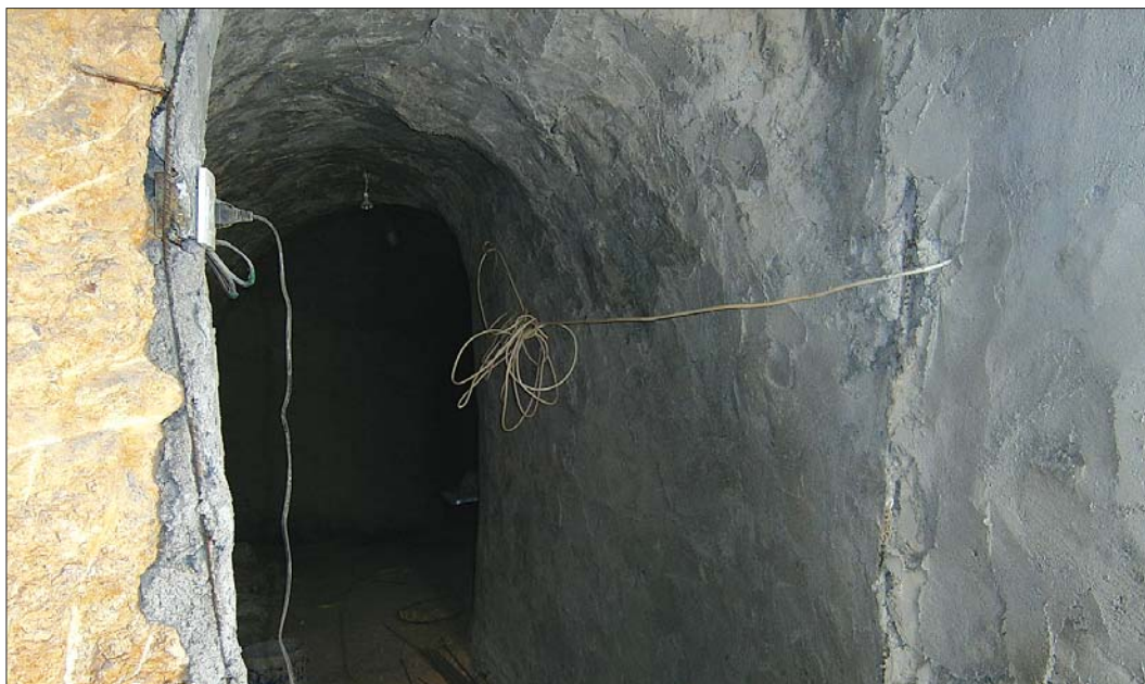
山洞内尚残留着一些加固用的钢筋。
