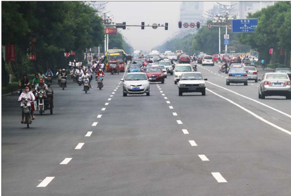
改造后的东昌路更加平坦，成为市区的样板路。
