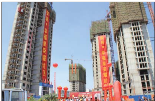
安居·幸福里一期封顶现场。李诚春 摄
