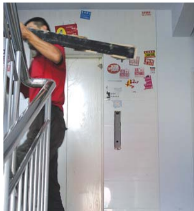
电梯没法用,装修工人往楼上扛物料。本报记者赵兴超 摄
