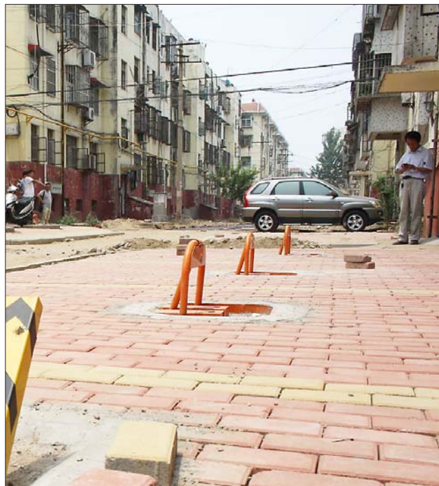
44号楼前,私自安装的地桩锁,其他车辆无法使用。
