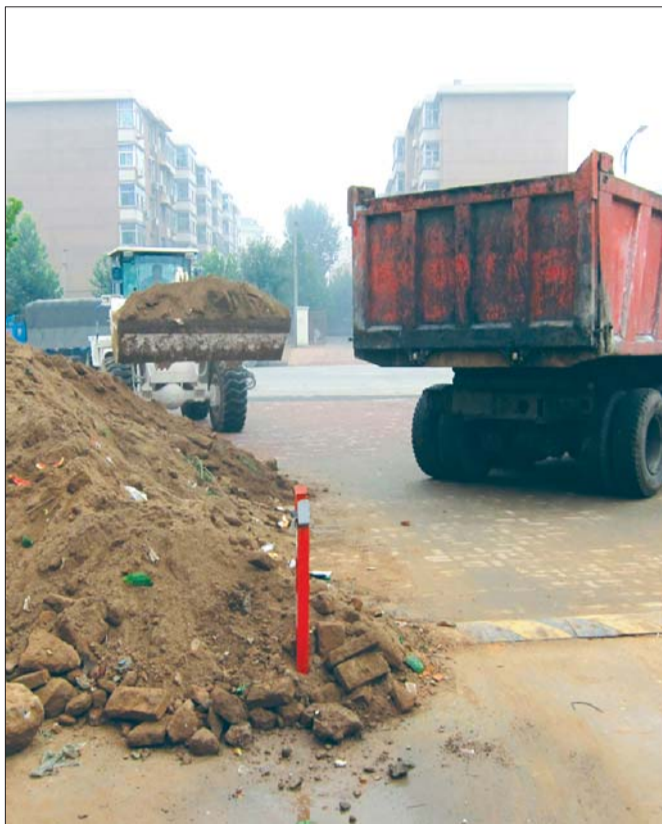
铲车正在清理堵门的土堆。 本报记者 王衍 摄
