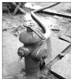
◀消防栓已经更换。庄子帆 摄
