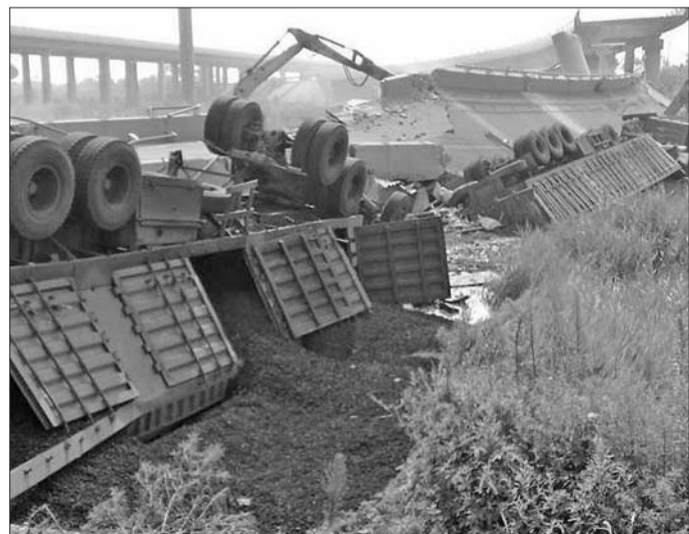
2009年7月15日津晋高速连续独柱墩匝道桥倾覆事故现场。(资料片)
