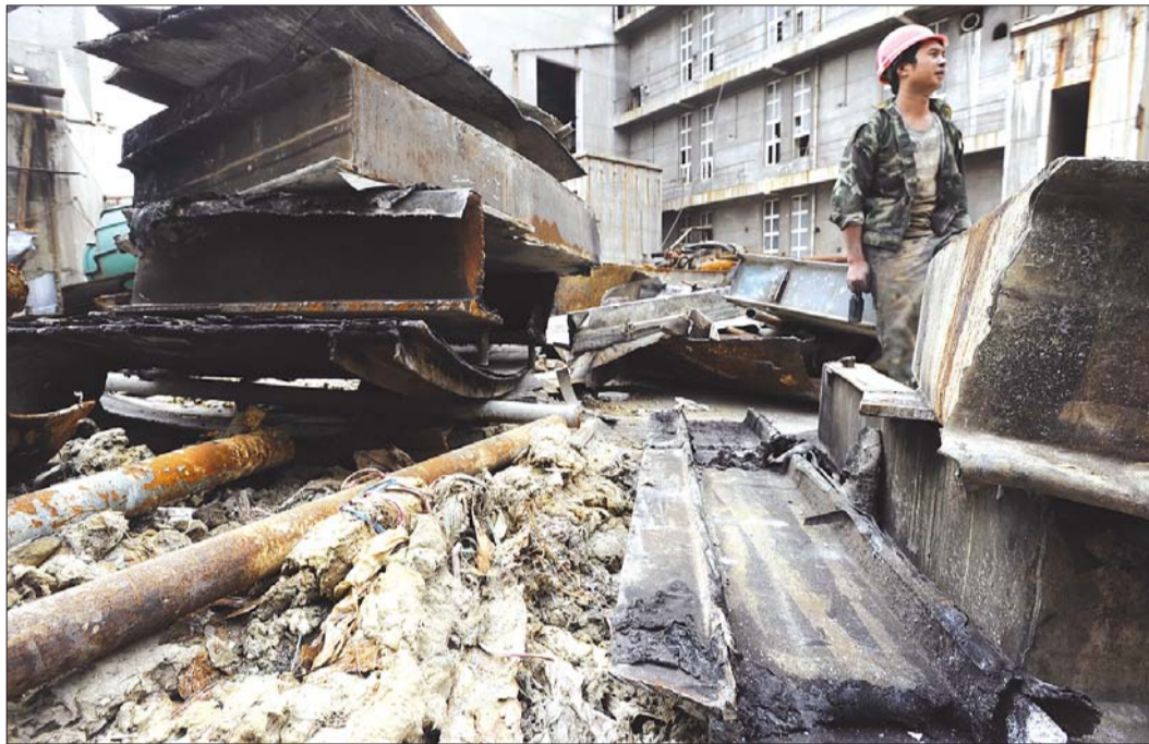
工人切割罐体时电焊火花引燃易燃物冒出浓烟,让周围市民以为是失火了。 本报记者 王媛 摄
