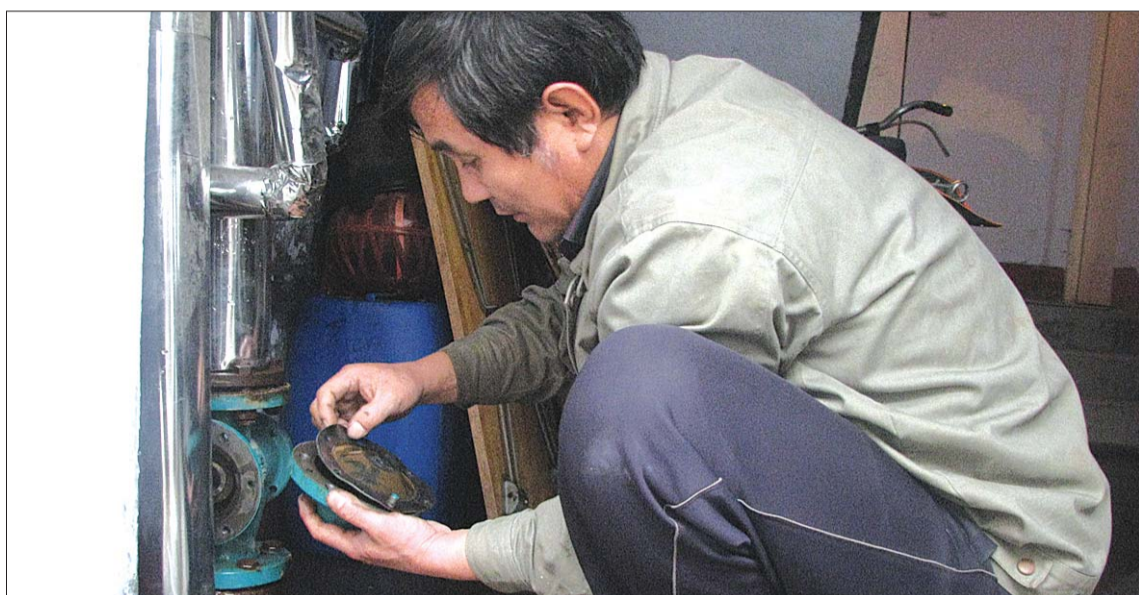
工作人员为用户疏通供暖管道。
