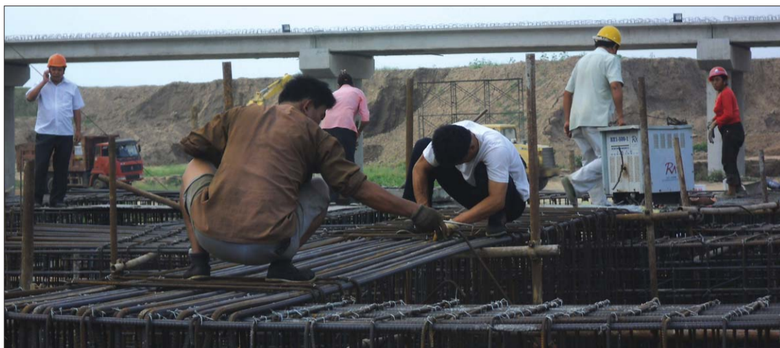
工人们正在焊接钢筋。
