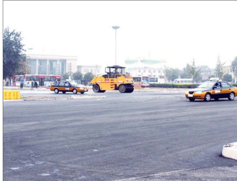
火车站路口沥青铺设完毕,已实现通车。本报记者 刘守善 摄
