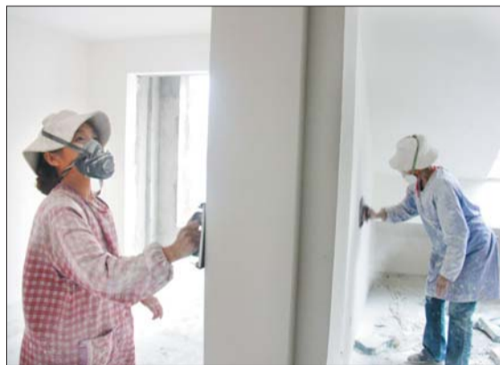
▲女工在工地上打磨墙皮。
