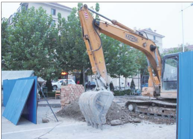
黄河十路渤海七路十字路口处正在施工。本报记者 杨青 摄
