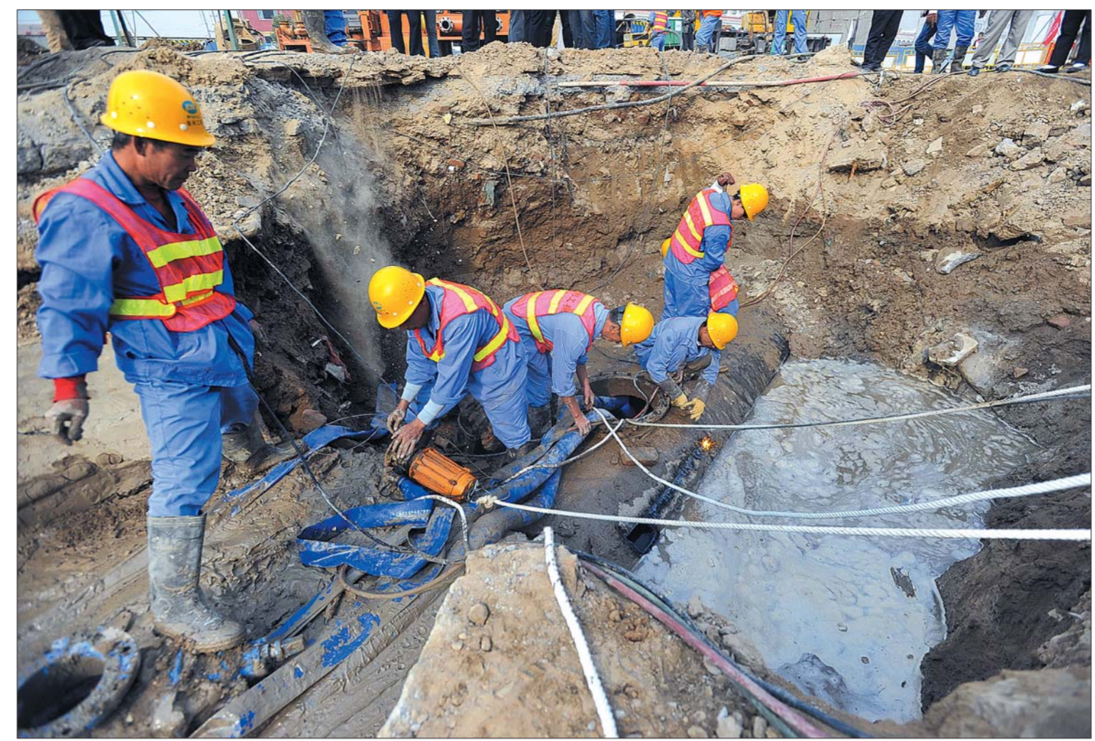
15日,在二环西路原水管道改造现场,施工工人们正一边切割旧管道一边用水泵抽水。
