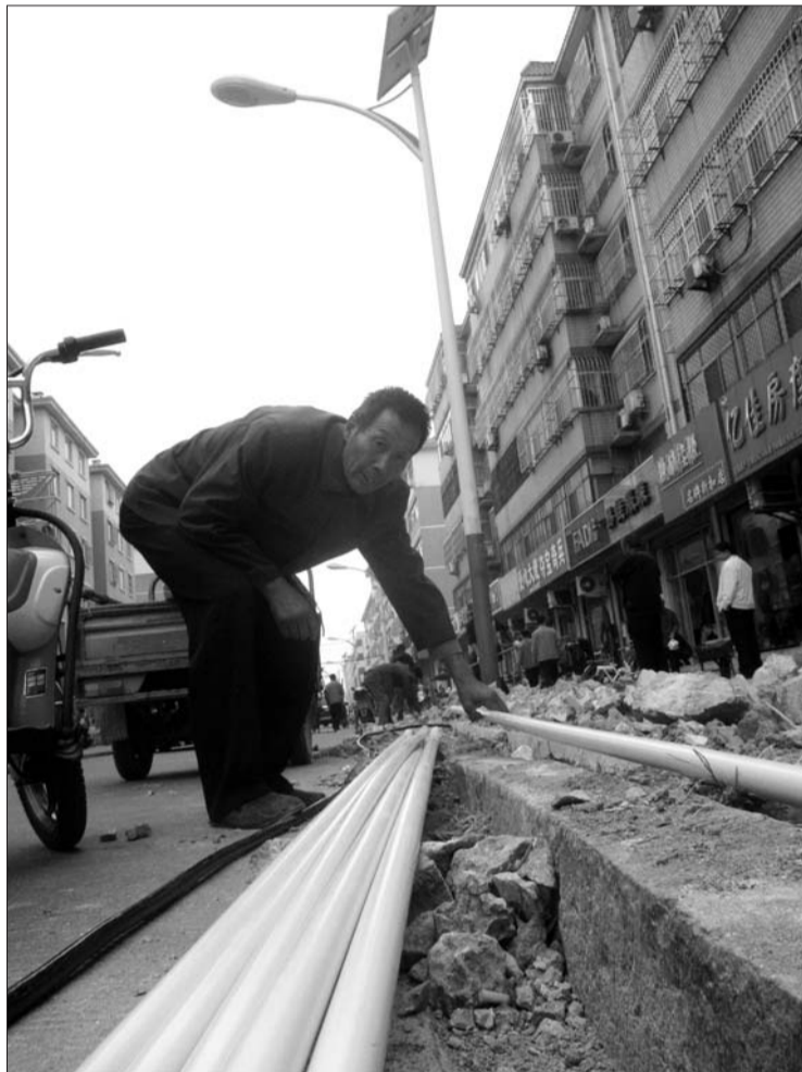
工作人员正在铺设线管。本报记者 王金强 摄
