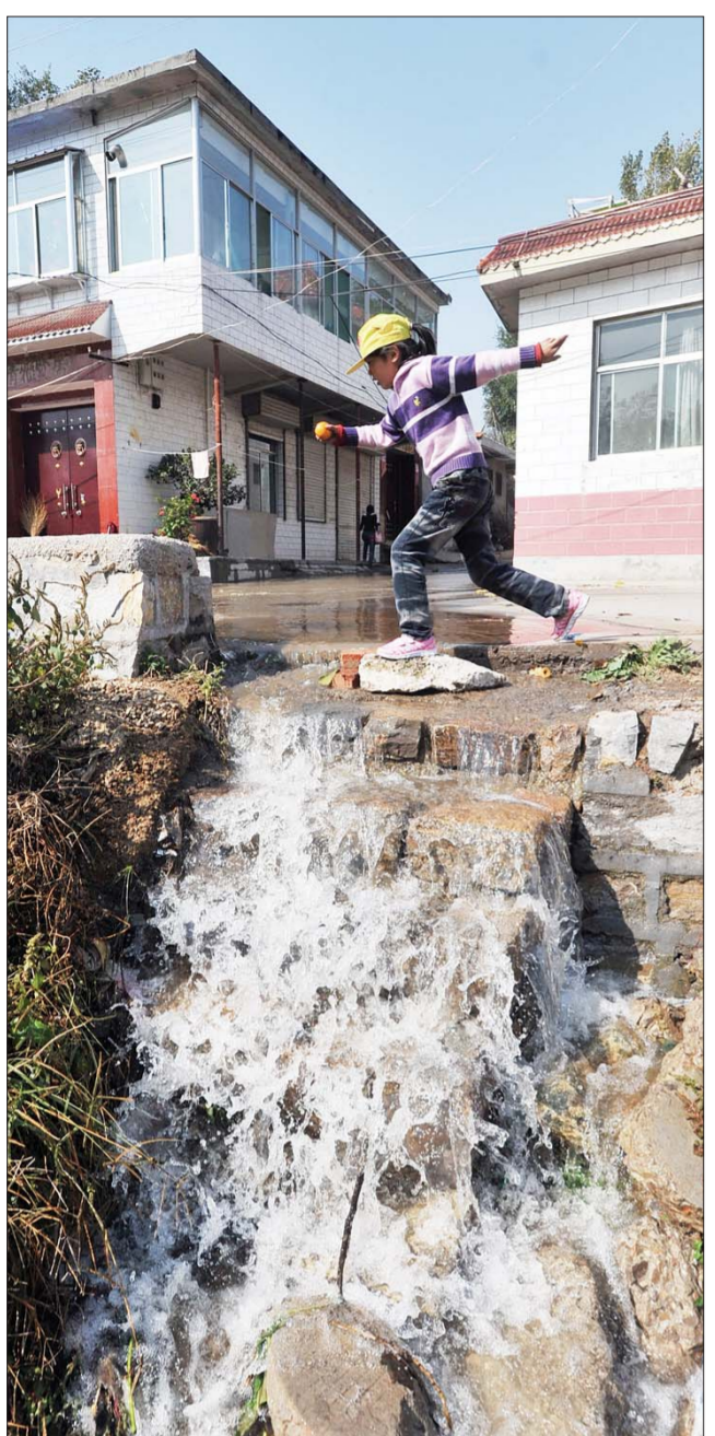
从发生滑坡的塘坝里抽出来的水,顺着泄洪道排到村头,漫过村口的路面,流入玉符河。 本报记者 徐延春 摄
