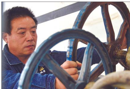
工作人员正在维修管道。(资料图)本报记者李岩松摄
